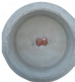
Sicht auf die Putzöffnung
