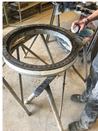
5. Den Beton-Guss großzügig mit dem Reinigungsspray ansprühen und kurz einwirken lassen.
