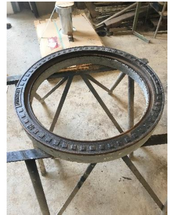
3. Die gesamten Rostrückstände beseitigen.
