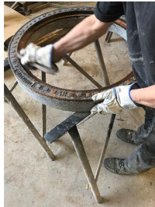
2. Mit einer Stahlbürste den Schmutz und Rost am Innenrahmen lösen und abkratzen.
