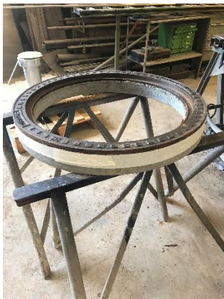
4. Falls der Deckel noch nicht eingebaut ist, den Betonrahmen außen mit Malerkreppband abkleben.
