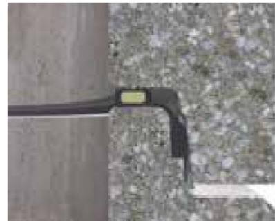
Foto Quelle: DS Dichtungstechnik GmbH
