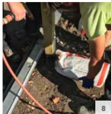
8. Weitere Lagen einbringen Befüllung lagenweise wiederholen, bis das Bodenloch gefüllt ist.
