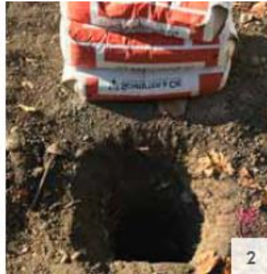
2. Vorbereitung Sackware in ausreichender Menge auslegen.
