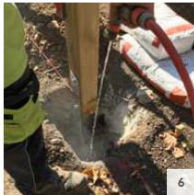
6. Wasserzugabe Erste Lage Blitz-Trocken-Beton wassersättigen.
