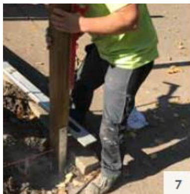
7. Säule o. ä. ausrichten Sofort lotrecht ausrichten.
