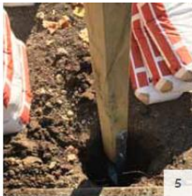
5. Säule o. ä. setzen Pfahl o. ä. horizontal und vertikal grob ausrichten.
