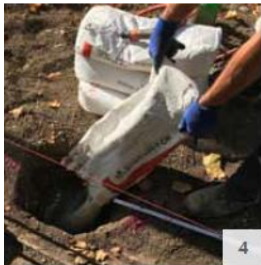
4. Erste Lage einbringen Trockengemisch in Lagen von 10-15 cm einfüllen.
