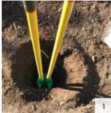
1. Aushub Ausreichend großes Bodenloch ausheben.
