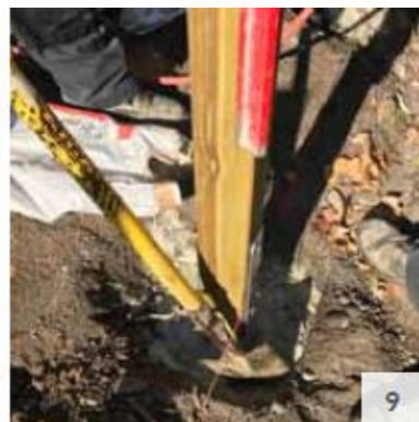
9. Stochern Zusätzliches Stochern mit Spaten o. ä. verbessert die Betonqualität.
