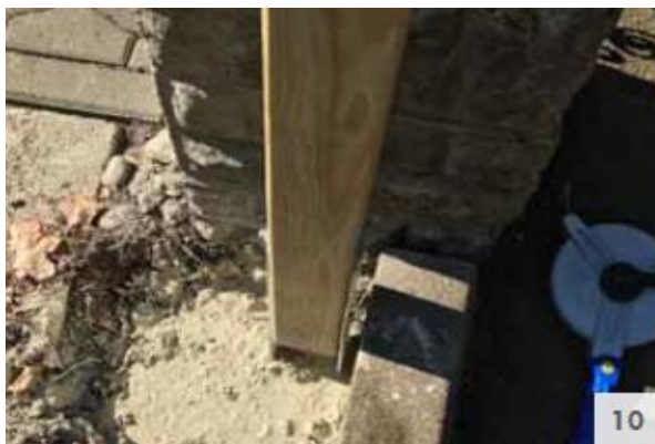
10. Betonage fertig Säule ist fixiert.
